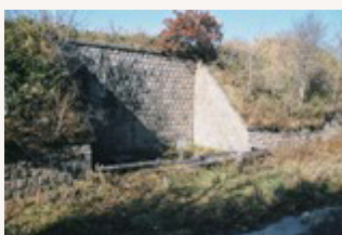
ろ過水槽および貯水槽跡
