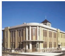
5 沖之口役所跡 (現函館市臨海研究所)
