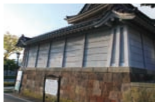
東本願寺函館別院附属コンクリート塀
