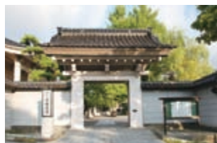
東本願寺函館別院附属南門
